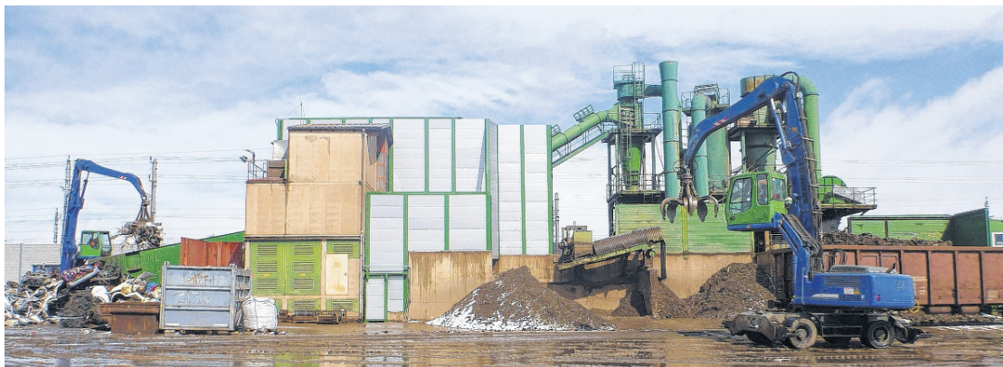
Der Groß-Schredder der Firma Müller-Guttenbrunn wurde mit einer Lärmschutz-Hülle versehen.
