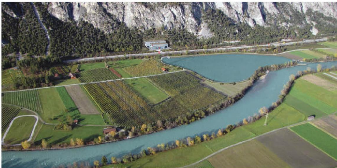
Die Kraftwerksstufe Imst-Haiming wurde nun bei der Behörde für das UVP-Verfahren eingereicht. Fotos: TIWAG
